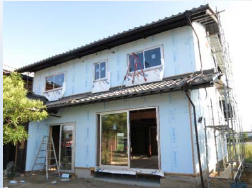
断熱材の設置
